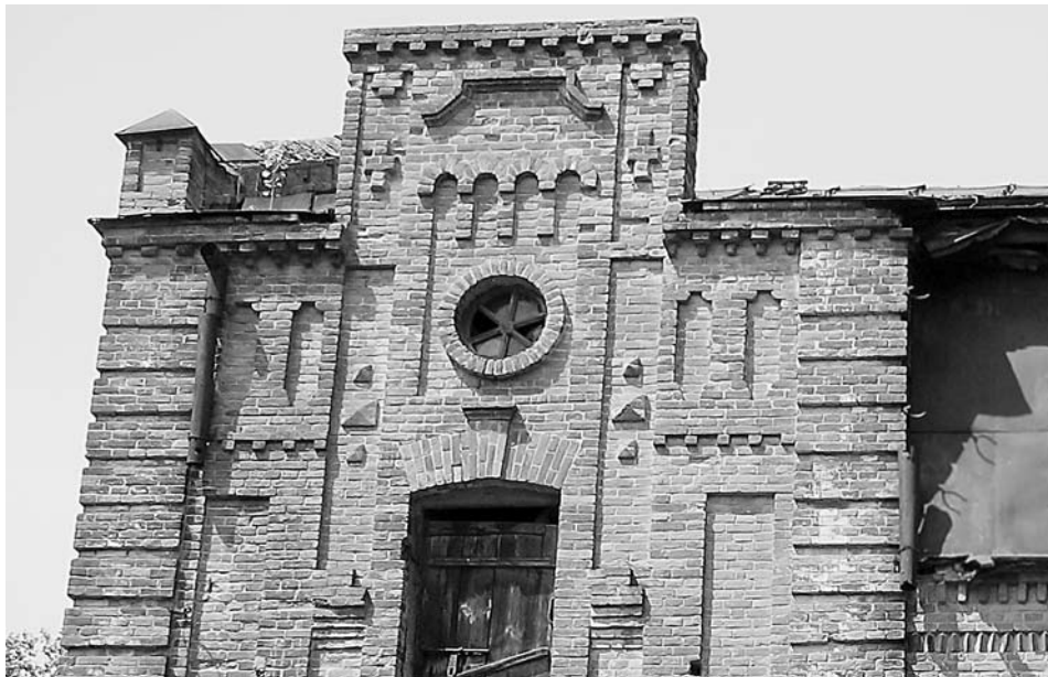
Рис. 3. Верхняя часть флигеля кирпичной водяной мельницы (1896) на реке Рось (верховья) в с. Круподеренцы Погребищенского р-на Винницкой обл. Пример «кирпичного стиля» в оформлении экстерьера сооружения.
